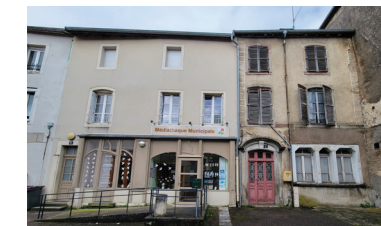
2. Médiathèque et logements vacants
