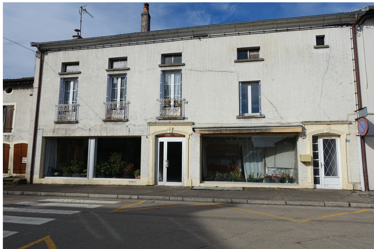
Bâtiment de l'ancienne quincaillerie de Monthureux-sur-Saône
